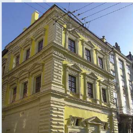
Палац Бандинеллі – котельня «Укрінтерм» 0,5 МВт.
