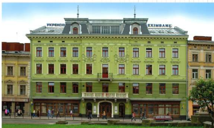
«Укресімбанк» – котельня системи «Укрінтерм» потужністю 1,0 МВт з окремо стоячим індивідуальним тепловим пунктом 0,8 МВт.
