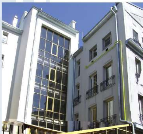
Адміністративно-торговий центр «інтергалбуд» – котельня 0,4 МВт.
